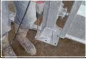
L'ensemble est boulonné sur une dalle béton et reste donc évolutif.
